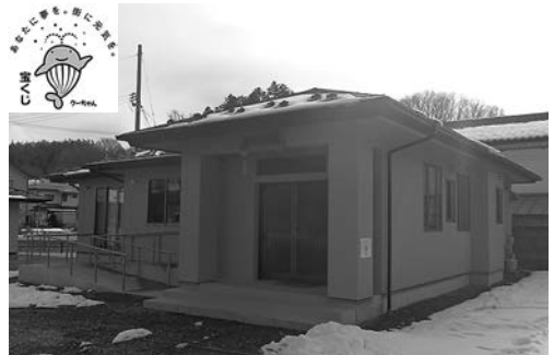
建設した中町公民館
