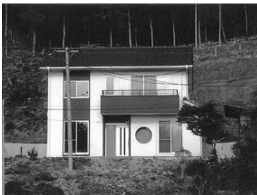
第21回建築賞受賞建物
