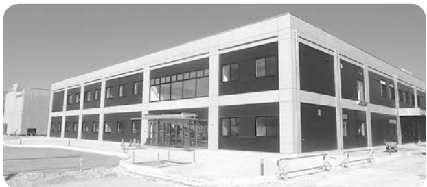
本館写真（一部外構工事が未完）
