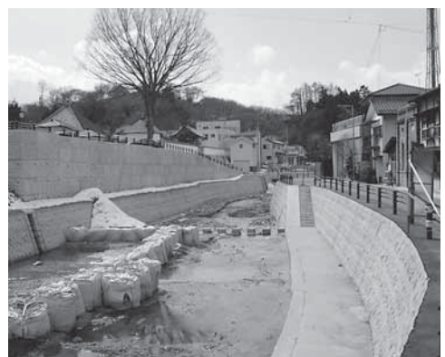
改修工事が進む桜川
